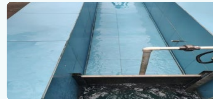
混凝沉淀池改造
