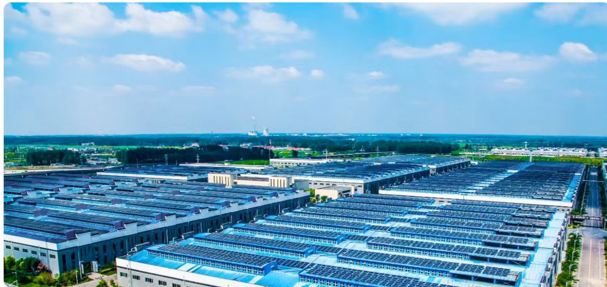
洋河分公司屋顶光伏
